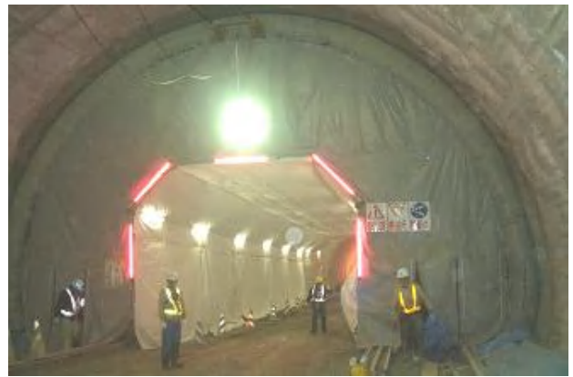
同左 養生シート貼付
