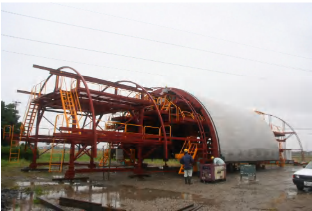
セントル養生・コンクリート湿潤養生一体型システム
