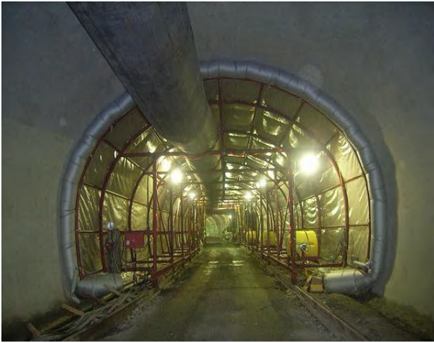
コンクリート湿潤養生システム NETIS登録No.CG-080012-A
