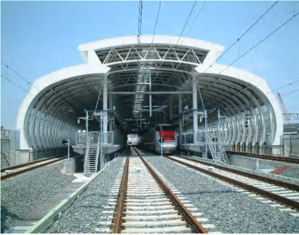
東北新幹線八戸駅舎
