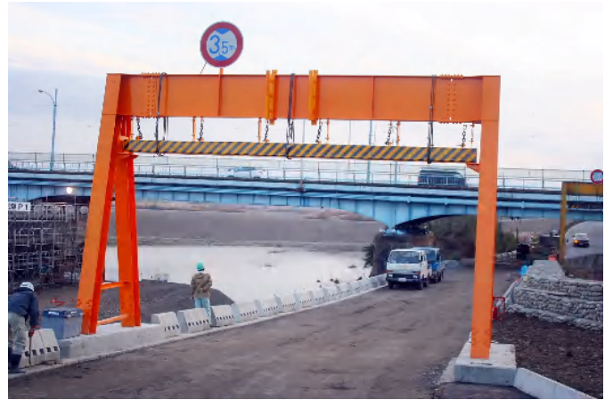
富山大橋高さ制限門構
