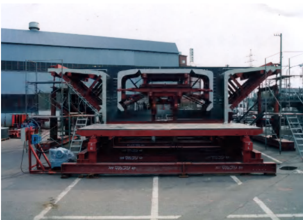
橋梁上部エセグメント型枠
