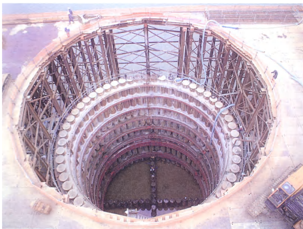
石狩川橋脚補強リング
