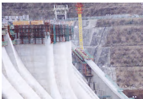
ダム堤体型枠
