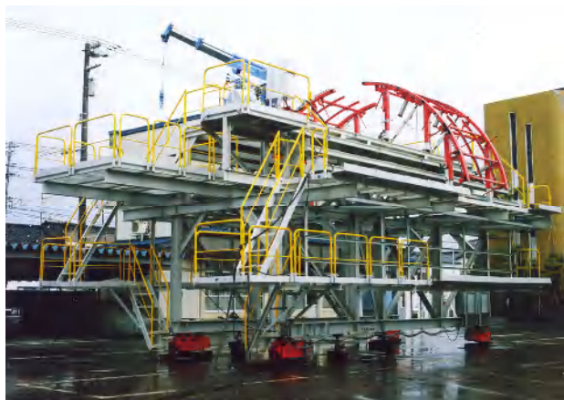
カーゴクレーン付鉄筋台車
