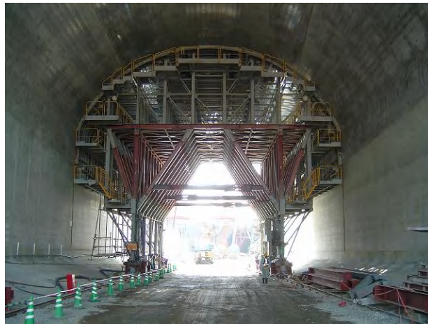
同上 高速道路部移動セントル
