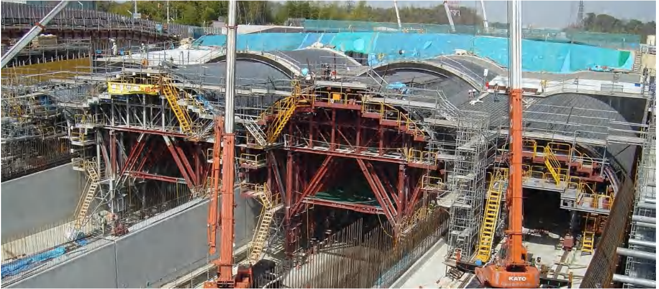
4連メガトンネル移動セントル
