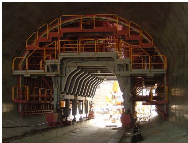
同上 一般道路部移動セントル
