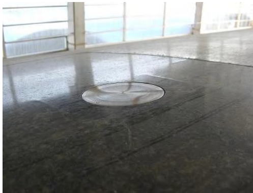
圧力センサー(型枠表面)
