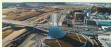
高速横浜環状北線新横浜換気塔
